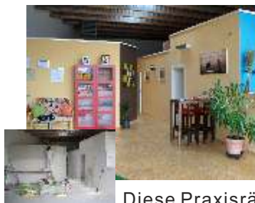
Diese Praxisräume wurden komplett im MAGU IN System erstellt, Auf die Behandlungszimmer wurde eine Holzbalkendecke als Raumabschluss gelegt - die Holzbalken wurden einfach in die MAGU IN Wand eingeschnitten.
