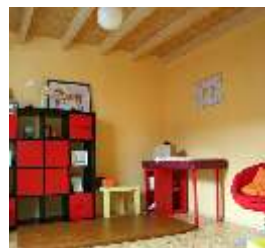
Diese Praxisräume wurden komplett im MAGU IN System erstellt, Auf die Behandlungszimmer wurde eine Holzbalkendecke als Raumabschluss gelegt - die Holzbalken wurden einfach in die MAGU IN Wand eingeschnitten.
