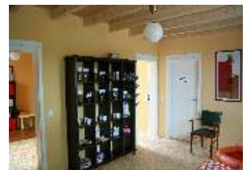
Diese Praxisräume wurden komplett im MAGU IN System erstellt, Auf die Behandlungszimmer wurde eine Holzbalkendecke als Raumabschluss gelegt - die Holzbalken wurden einfach in die MAGU IN Wand eingeschnitten.
